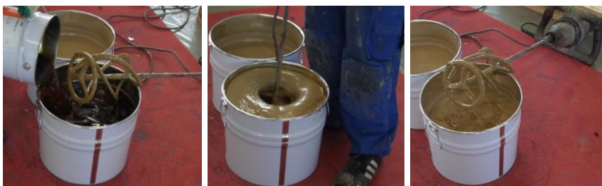
Mischen des 2-komponentigen PU Klebstoffes
