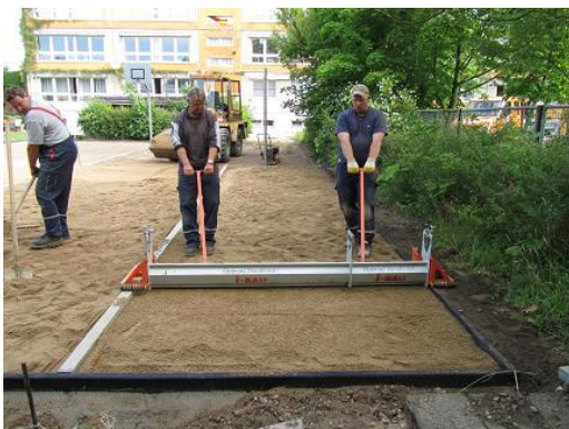
Brechsand/Splittgemisch 0/5 mm, 0/8 mm oder vergleichbar eben nivellieren, standfest verdichten
