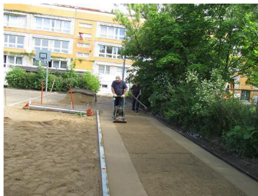
Brechsand/Splittgemisch 0/5 mm, 0/8 mm oder vergleichbar eben nivellieren, standfest verdichten
