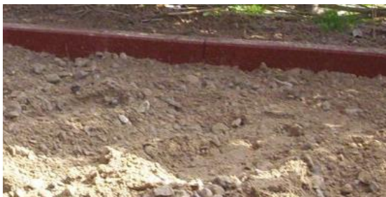
Unterbau aus Schotter 0-32 mm
